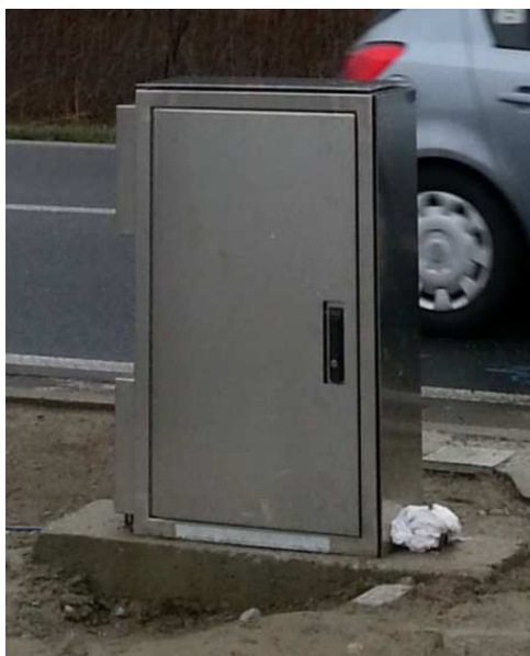
Foto dell'armadio posato in opera
