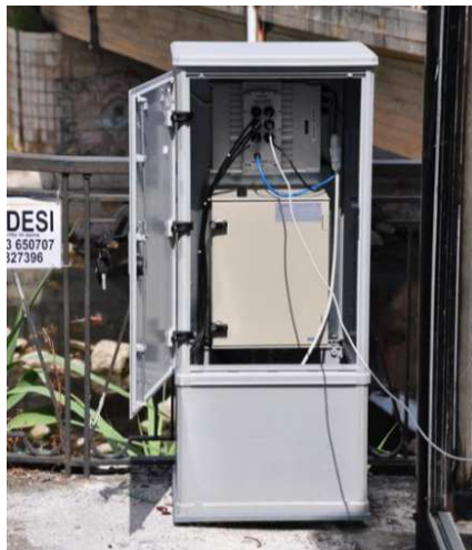
Esempio di installazione all'interno di armadio in vetroresina
